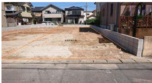
現地土地写真 東側及び北側にブロック積み施工しています。
